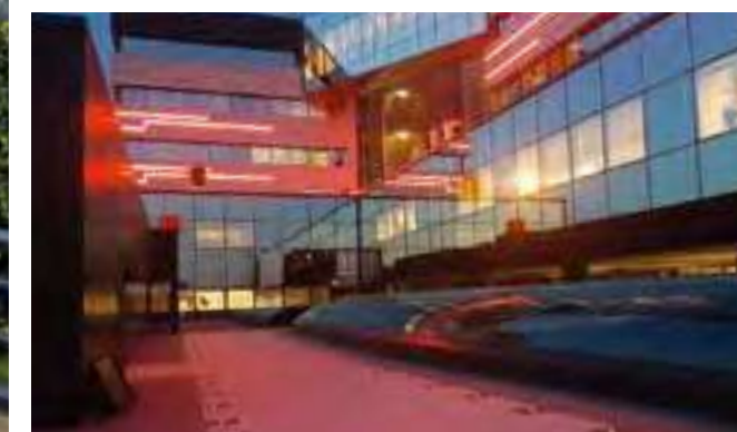
Facciata Centro Direzionale Lucrezia Romana
