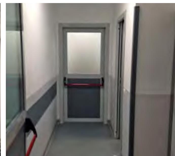
Corridoio con porte antipanico
